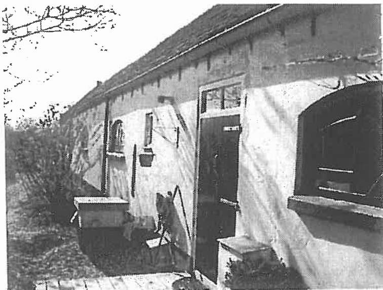
De linker zijgevel van het zomerhuis/bijgebouw is authentiek met een nieuwe ingebrachte deur voor de woonfunctie.
