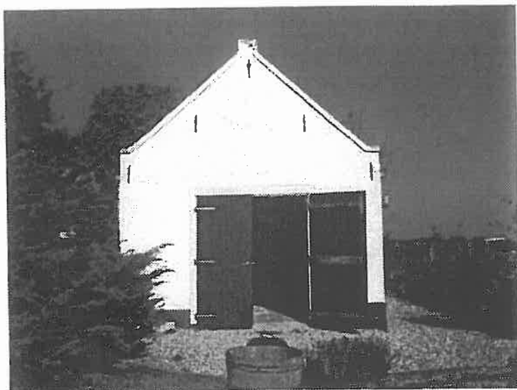
Achtergevel van het zomerhuis/bijgebouw, gewijzigde entree
